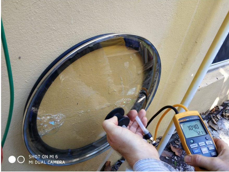
Bina kabuğu elemanları hava geçirimsizlik testi (Bubble Gun testing) (ASTM E 1186)
