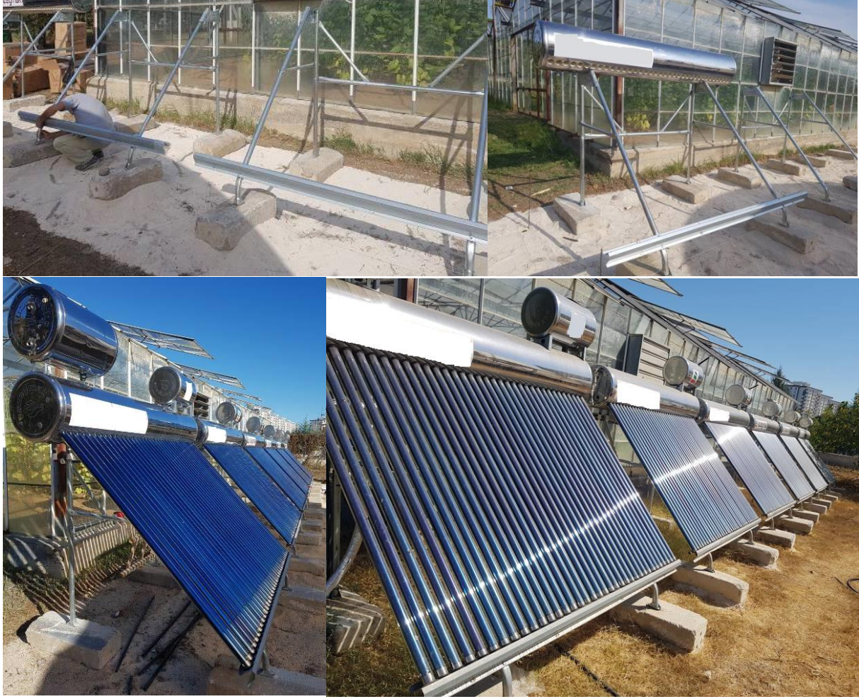
Şekil 2. Vakum borulu toplaçlarından oluşan ısı toplama ünitesi
