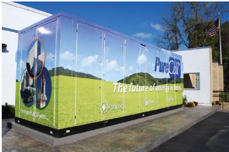
Şekil 3 400kWe Kapasitesine sahip FAYP tipi yakıt pili [6]
