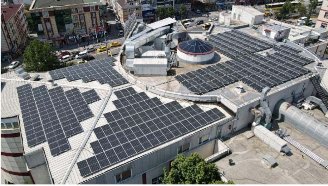
Şekil 6 İstanbul Esenyurt Necmi Kadioğlu Devlet Hastanesi Enerji Verimliliği Uygulamaları ve Çatı Üstü Güneş Enerjisi Santrali Uygulaması
