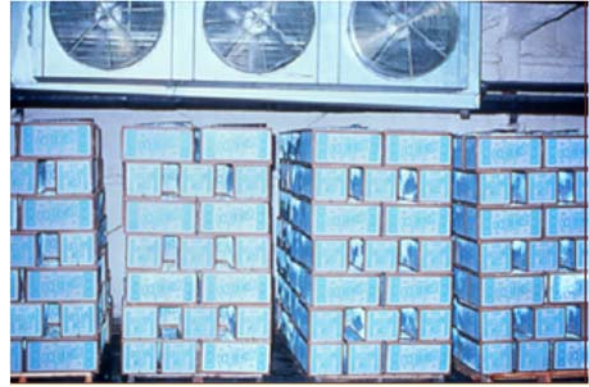
Şekil 7. Odada önsoğutma çalışma prensibi, seyrek istifli yerleşim. [5, 13].
