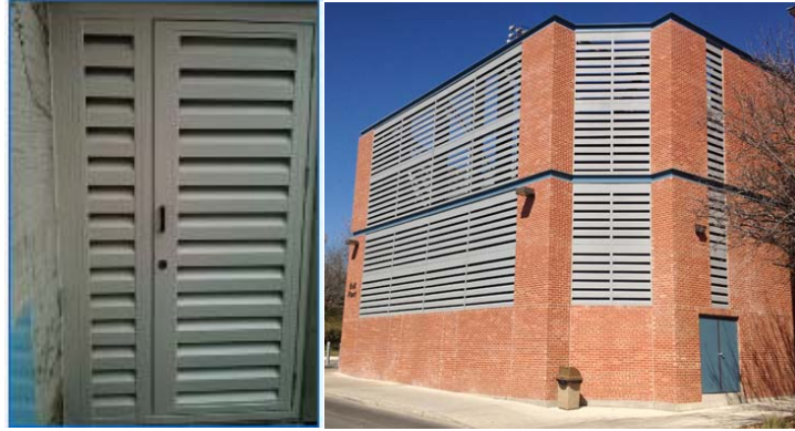
Şekil 9. Ses Yalıtımlı Kapılar ve Hava Menhollerine Örnek
